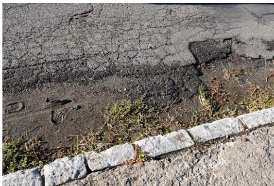
Obr. 37 Stav vozovky pri chodníku
