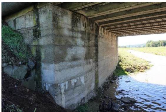
Obr. 51 Poškodenie obkladu svahu – opora 3
