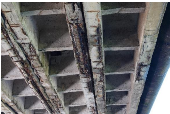
Obr. 30 Korózia výstuží - pole 1, ľavá strana
