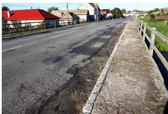
Obr. 34 Neodtekajúca voda na vozovke
