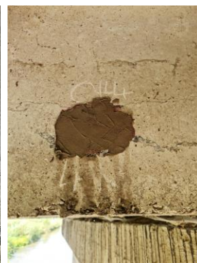
Obr. 65 Poloha a oprava miesta odberu vzoriek C4
