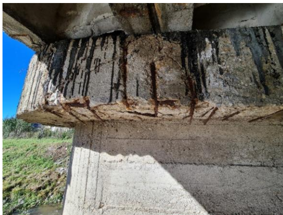
Obr. 19 Korózia výstuže úložného prahu podpery
