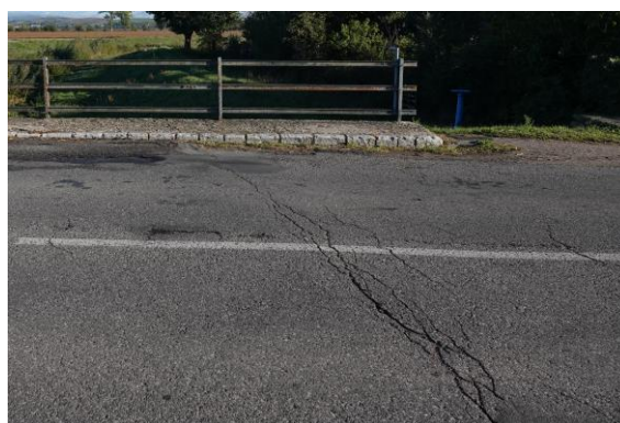
Obr. 35 Trhlina v mieste dilatácie – opora 3
