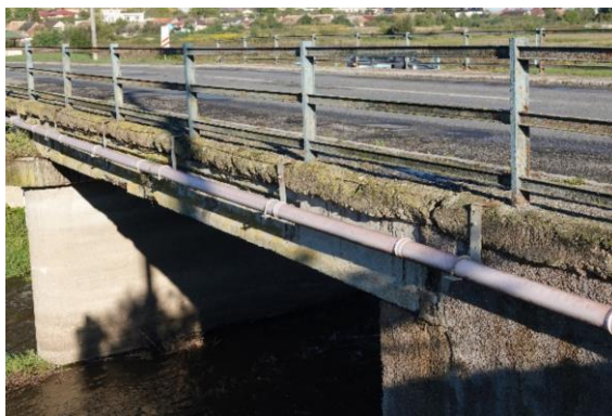
Obr. 8 Chránička s vedením na výtokovej strane
