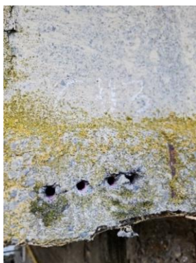
Obr. 64 Poloha a oprava miesta odberu vzoriek C3
