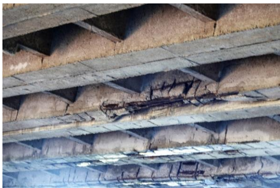
Obr. 28 Korózia káblov - pole 1, ľavá strana
