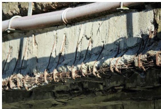
Obr. 29 Porucha kábla - pole 1, pravá strana
