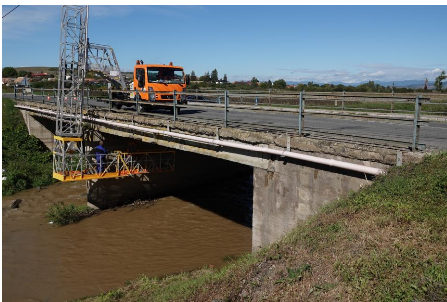
Obr. 9 Kontrola mosta z plošiny BARIN
