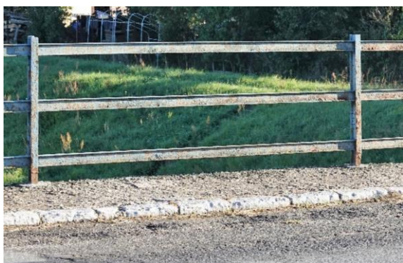
Obr. 48 Povrchová hrdza zábradlia
