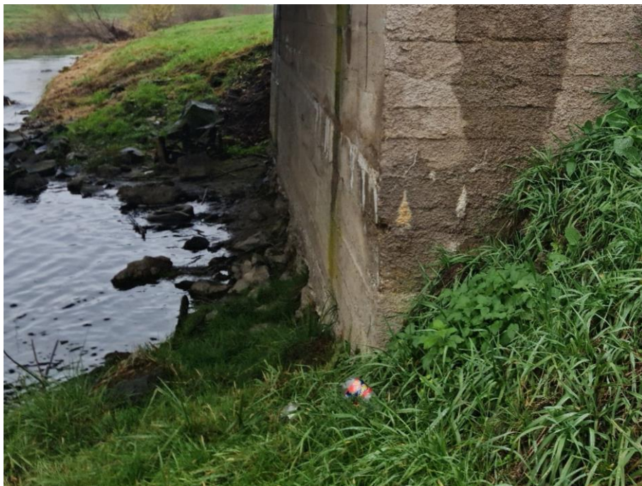
Obr. 6 Pohľad na oporu a súčasný stav obkladu svahu
