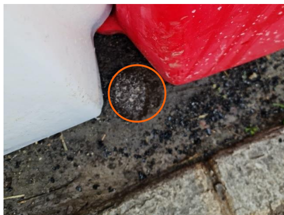
Obr. 57 Vyplnené miesto vývrtu vo vozovke
