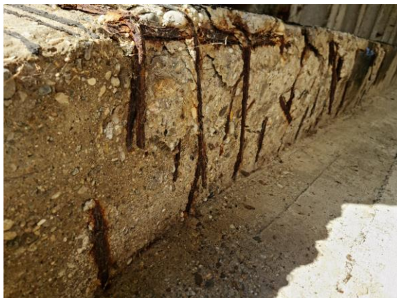
Obr. 75 Výstuže úložného prahu podpery
