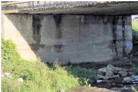
Obr. 50 Poškodenie obkladu svahu - opora 1
