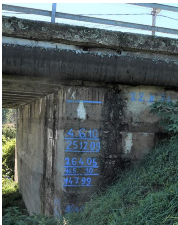
Obr. 45 Zatekanie opory 1 cez dilatáciu
