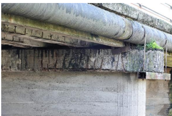
Obr. 20 Korózia výstuže a znečistenie ÚP podpery
