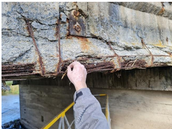
Obr. 78 Overovanie počtu drôtov predpätej výstuže
