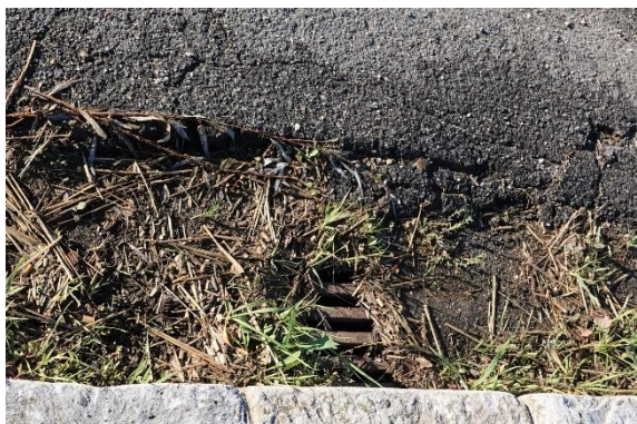
Obr. 46 Pohľad na zanesený odvodňovač
