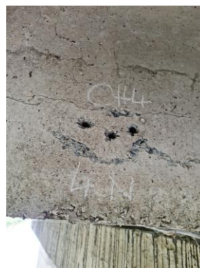
Obr. 65 Poloha a oprava miesta odberu vzoriek C4
