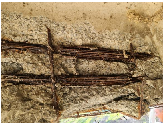
Obr. 30 Korózia výstuží - pole 1, ľavá strana
