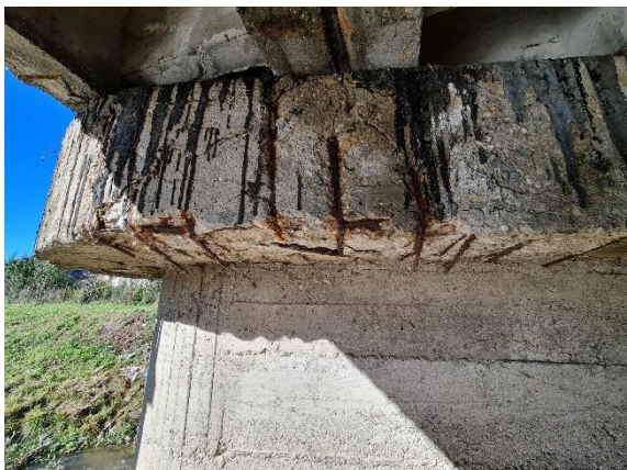
Obr. 74 Výstuže úložného prahu podpery
