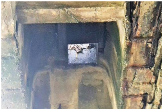
Obr. 47 Krátka výtoková rúra, zatekanie okolo odvodňovača
