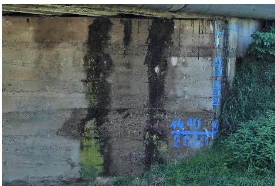
Obr. 23 Zatekanie na opore 1- ľavá strana
