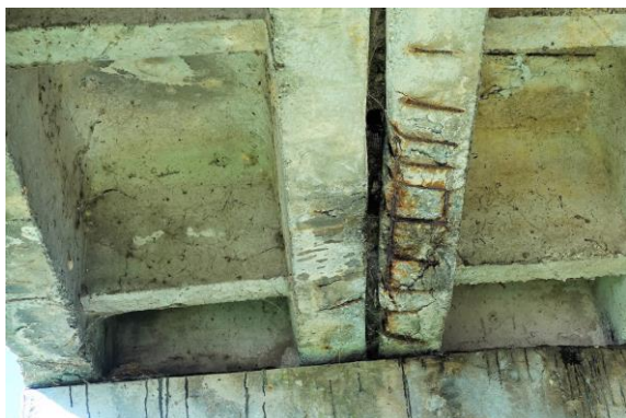
Obr. 72 Korózia mäkkej výstuže nosníkov
