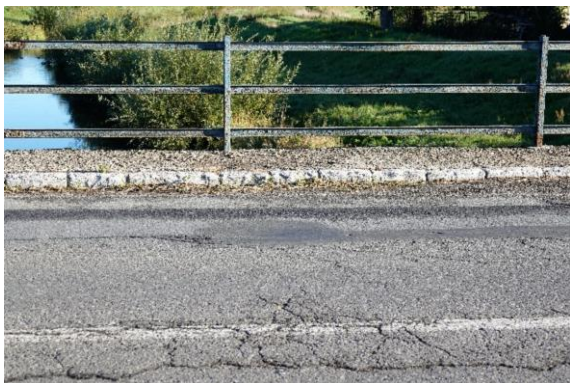
Obr. 36 Pozdĺžna trhlina v strede vozovky
