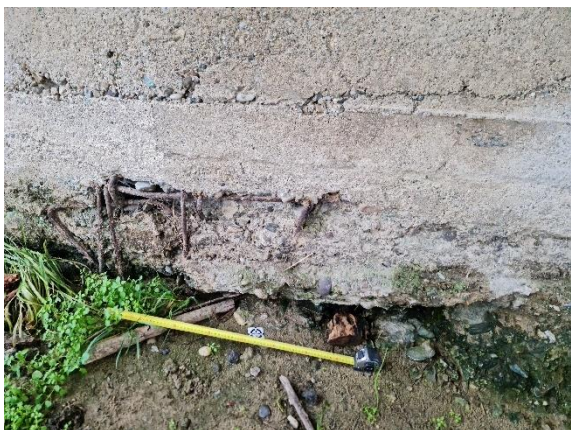
Obr. 76 Výstuž základu opory
