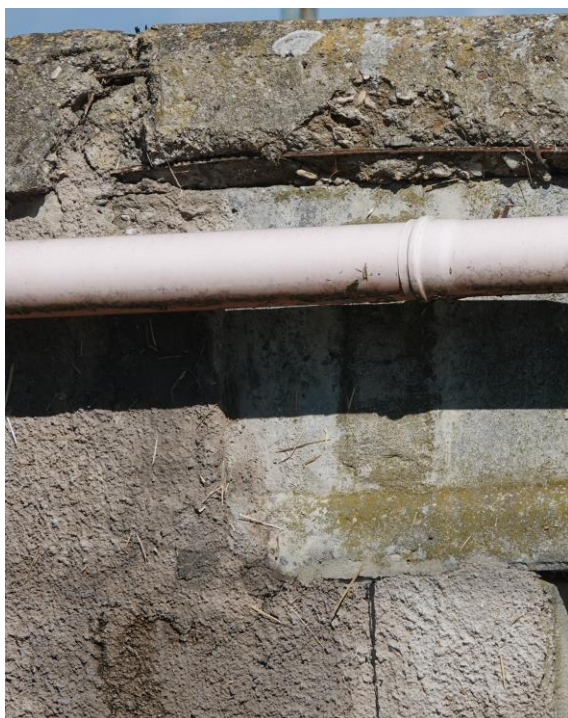
Obr. 44 Zablokovanie pohybu NK v mieste dilatácie
