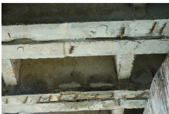
Obr. 71 Korózia mäkkej výstuže nosníkov
