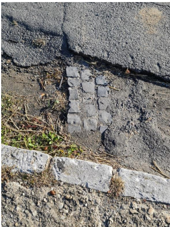
Obr. 42 Pohľad na neprekrytý úsek dilatácie - opora 3
