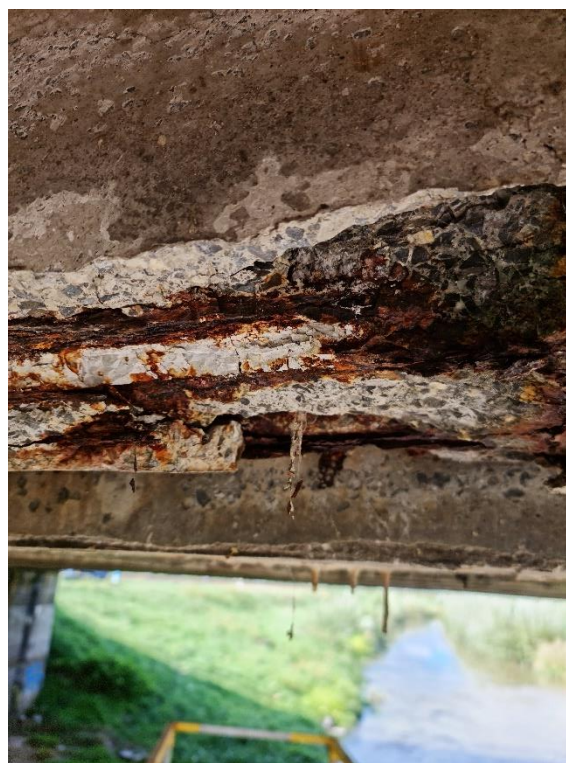
Obr. 81 Skorodovaná zainjektovaná predpätá výstuž
