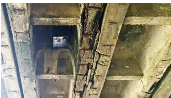
Obr. 38 Zatekanie NK - pole 2, pravá strana
