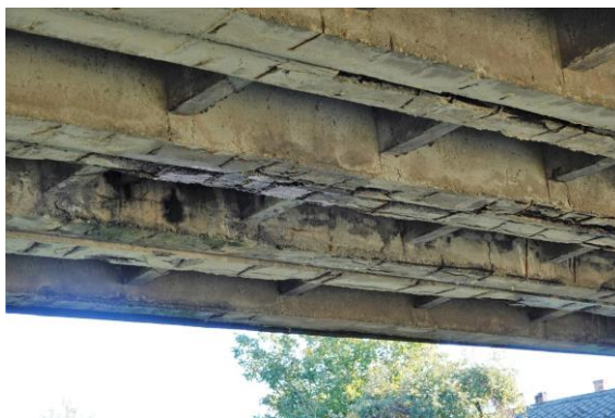
Obr. 27 Korózia káblov - pole 1, pravá strana
