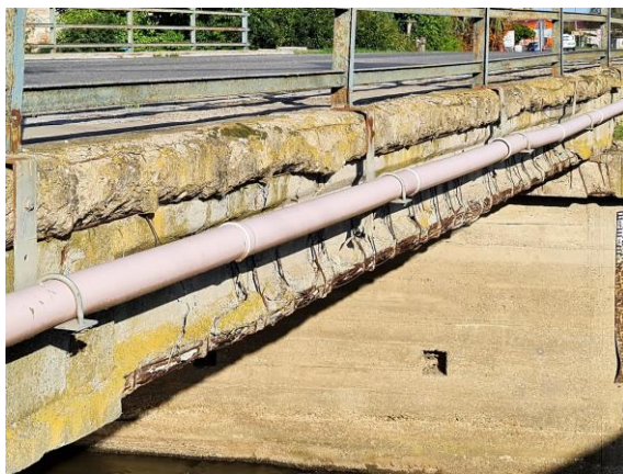
Obr. 31 Korózia výstuží - pole 1, pravá strana
