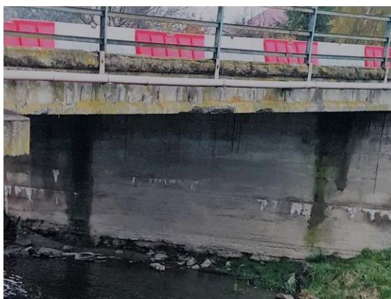
Obr. 21 Erózia základu, výluhy a zatekanie opory 3
