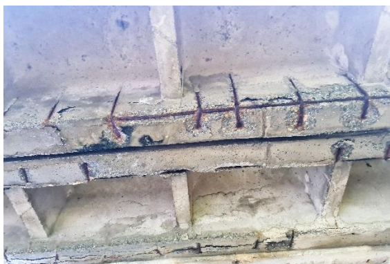
Obr. 73 Korózia mäkkej výstuže nosníkov
