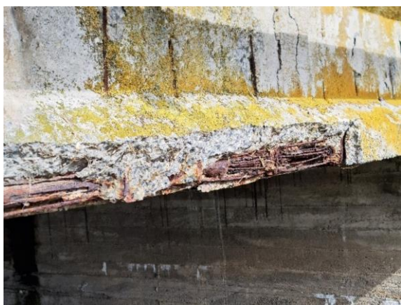
Obr. 26 Korózia káblov - pole 1, ľavá strana
