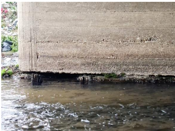
Obr. 18 Podomletie podpery na výtokovej strane
