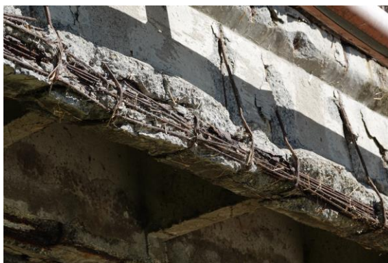
Obr. 25 Zatekanie a poruchy krajného nosníka
