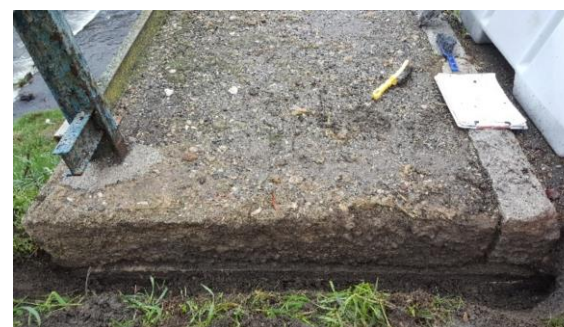
Obr. 39 Monolitický chodník na krídle
