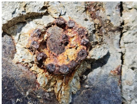
Obr. 79 Kotva priečnej predpätej výstuže
