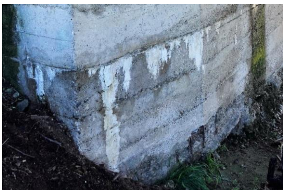
Obr. 22 Detiľ na poruchy na opore 3, ľavá strana
