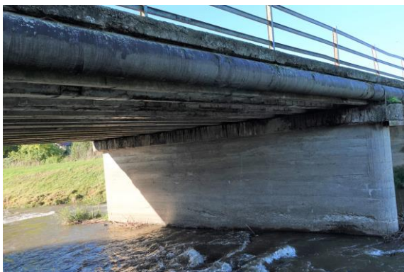
Obr. 7 Potrubie na vtokovej strane
