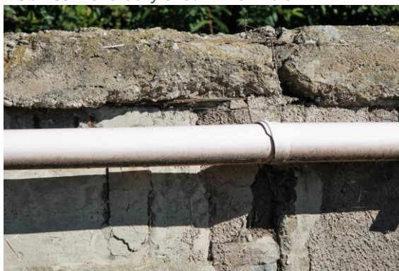
Obr. 41 Stav rímsy v mieste dilatácie na opore 3
