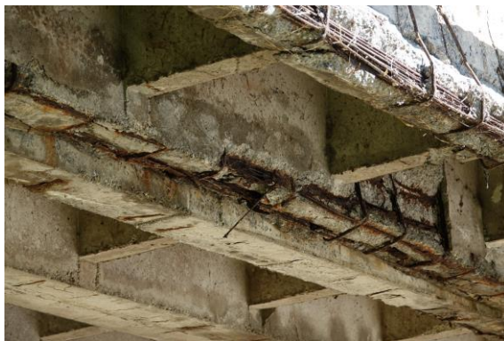
Obr. 31 Korózia výstuží - pole 1, pravá strana
