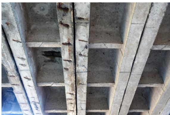
Obr. 24 Poruchy krytia mäkkej výstuže na NK
